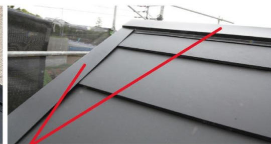
棟・ケラバ部などは既存の板金ですっきり仕上がります。 *周辺板金部は塗装されることをお勧めいたします。
