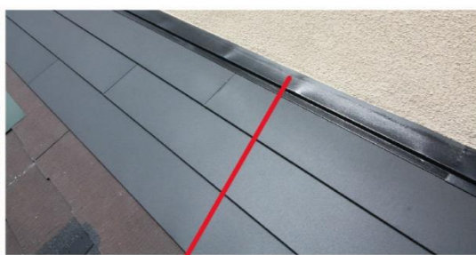
カバー工法では施工が大掛かりな雨押え板金はそのまま残して(塗装仕上げ)仕上げます。
