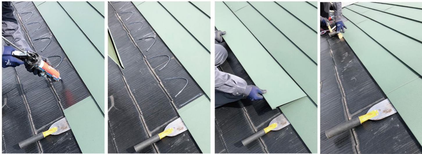
①屋根面を洗浄した後、専用接着剤を所定の方法で塗布します。
